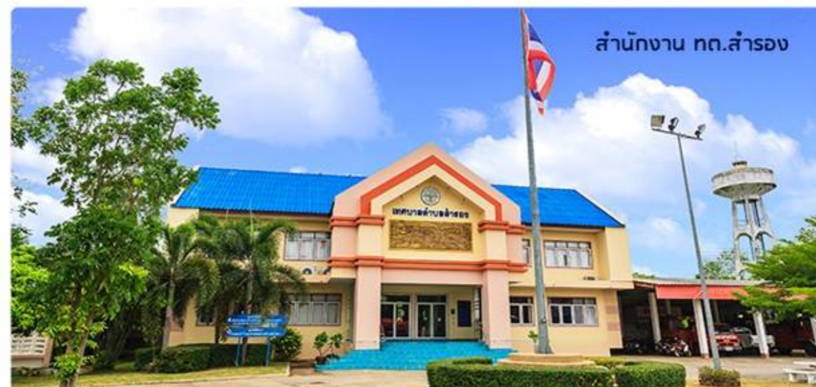
สำนักงานเทศบาลตำบลสำโรง เวลา 14.30 น.
